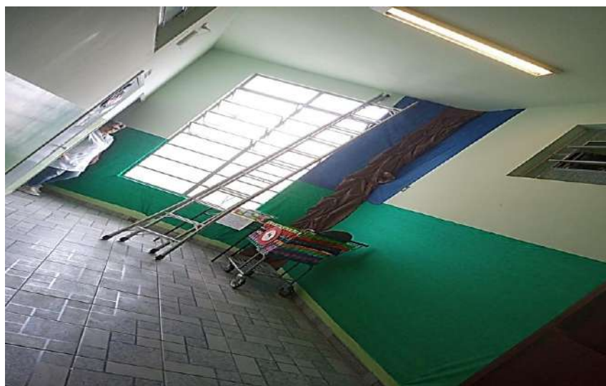
Figura 2 – Montagem do painel, 21 Novembro 2022. Acervo pessoal das autoras
